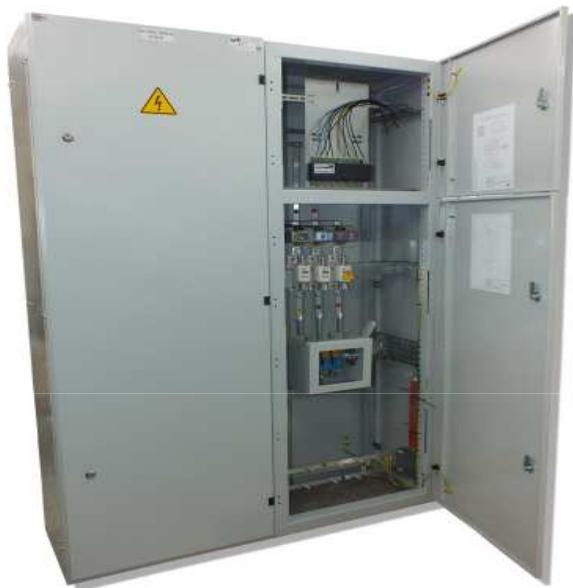
ВРУ 8504 собирается из отдельных панелей одностороннего обслуживания напольного исполнения и согласно предназначению разделяются на:
